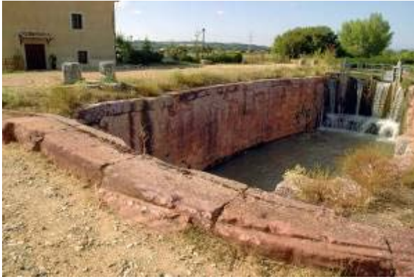
Esclusa del Canal de Castilla fabricada con la misma roca arenisca roja que el canal romano de los Anillos de Sasamón. Este lugar es cercano al de la cantera, en Herrera de Pisuerga (Palencia).
