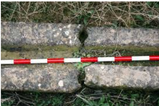
Canal de Andelos (Navarra), con detalle de la junta de estanqueidad.
