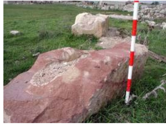
Pieza rota del canal de los Anillos en Olmillos de Sasamón, fabricada en roca arenisca roja procedente de Herrera de Pisuerga (Palencia).
